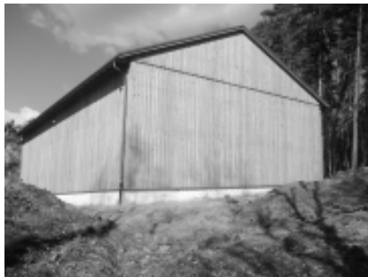
Der neue Hochbehälter beim Sportplatz
